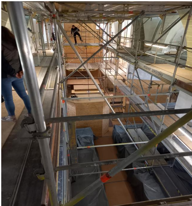
Ein spektakuläres Bild: Komplett eingerüstet gleicht die Eversberger Pfarrkirche momentan einer Großbaustelle.
